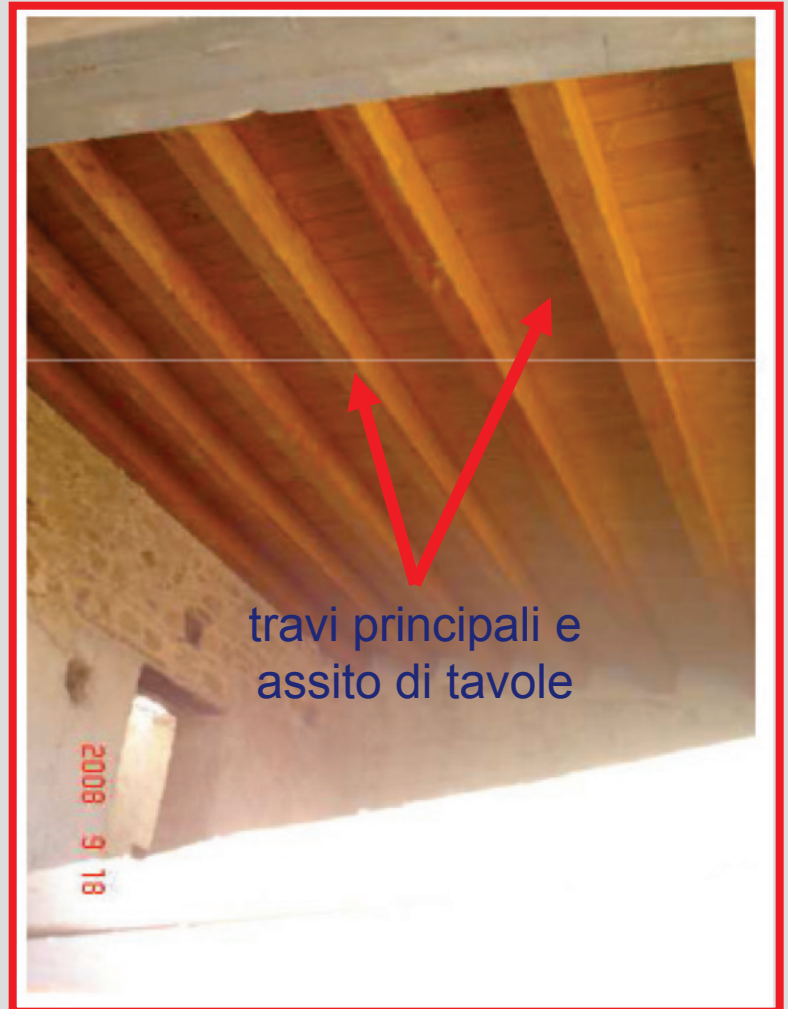
Solaio in legno lamellare
